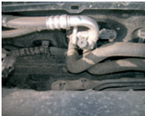
Złącze serwisowe obwodu niskiego ciśnienia układu klimatyzacji.
